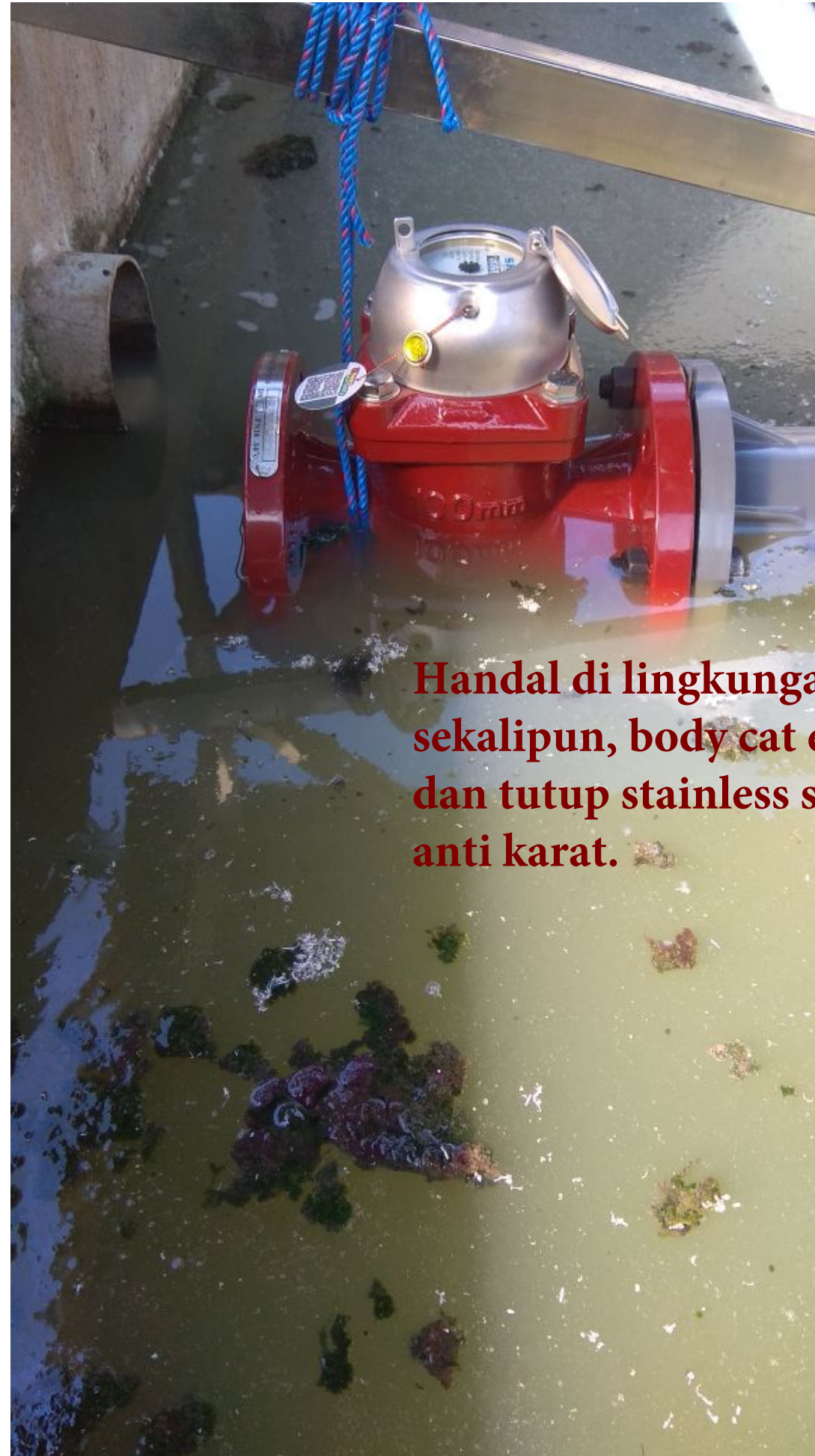
Cap/tutup bahan besi, sangat rawan korosi, apalagi pada posisi outdoor atau system limbah, jika tutup rusak, maka display kaca akan terlepas pada dudukannya dan flowmeter tidak bisa digunakan..
